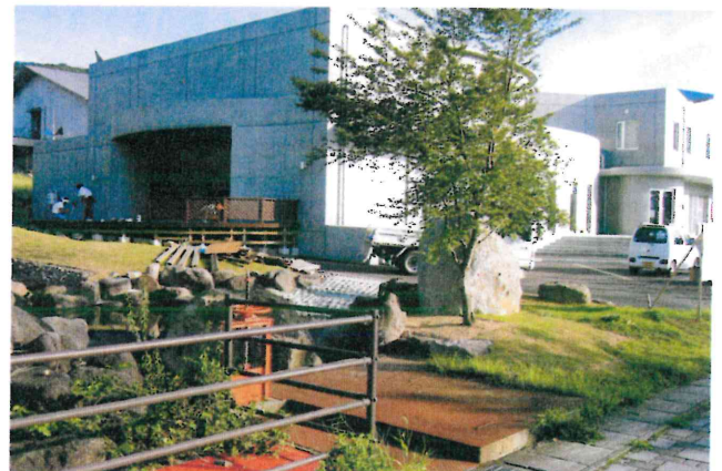
図6 上下：施工中 撮影：（株）ア・ファクトリー
